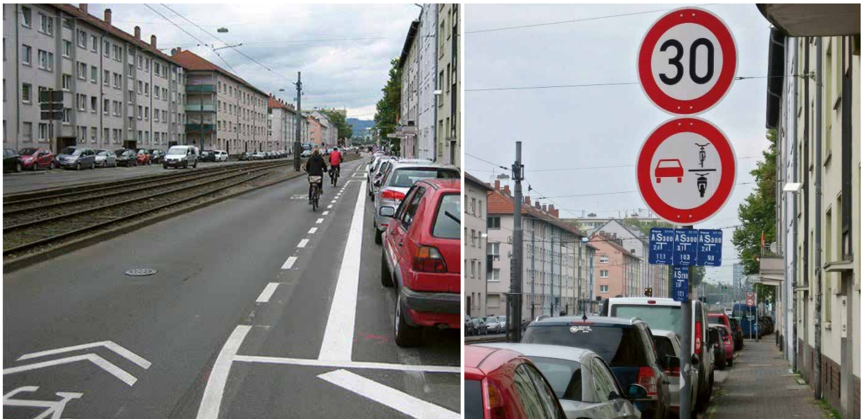
Bild 9: Überholverbot für einspurige Fahrzeuge, bike sharrows sowie Sicherheitstrennstreifen (0,75 m) zum Parken am Beispiel der Schlossstraße in Frankfurt (Quelle: https://www.adfc-frankfurt.de/ )
