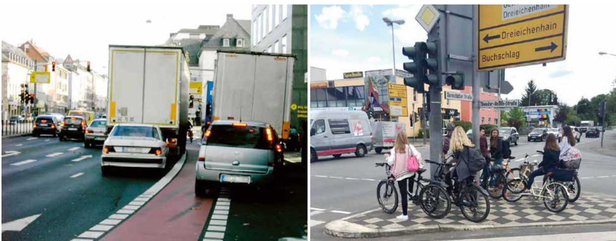
Bild 8: Konflikte für den Fuß- und Radverkehr durch unsichere Radführung am Knotenpunkt in Mittellage und ungeeignete Dreiecksinsel
